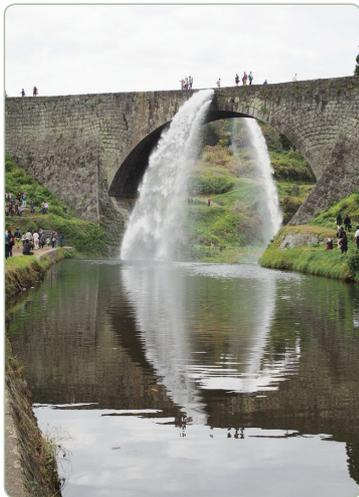
この橋は2つの地区を水路で結んでいるのですが橋の位置は2つの地区よりも低い位置にあります。そのため、水を通す時には噴水管は逆サイホンの原理を利用しているということです。ゴムなどのシーリング材がない時代に、石で作られた通水管の継ぎ目を漆喰で繋いで漏水しないように密封し、橋より高台の白糸台地まで用水を押し上げると言う高度な技術が用いられているということです。
